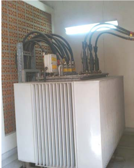
Gambar 1. Transformator tegangan menengah (20kV/400V, 2MVA)
